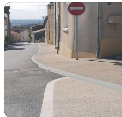
Bordures et caniveaux béton
