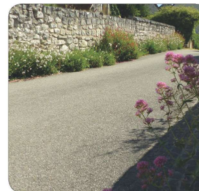
Végétalisation de pieds de mur
